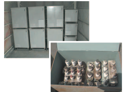
【PCB使用機器の保管状況例】
