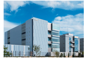
データセンター (岡山第3センター) ※
