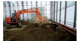
土壌の掘削作業
