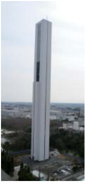
日立製作所都市開発システム社水戸事業所内 新エレベーター研究塔
