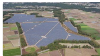
いちご昭和村生越 ECO発電所 竣工 (2017年10月)
