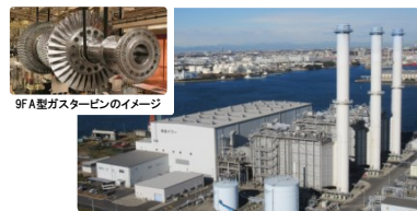
扇島パワーAGP化 改造工事受注 (2018年2月)
